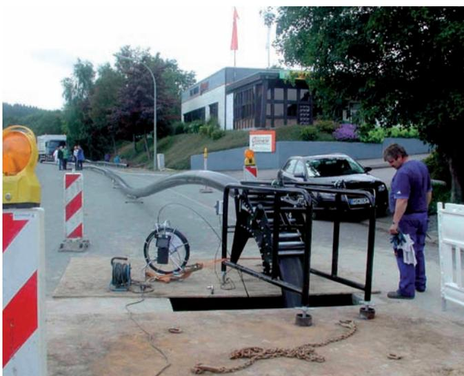
**Bild 11:** Einzug des verschweißten Langrohrstrangs durch die obere Verformungseinheit
