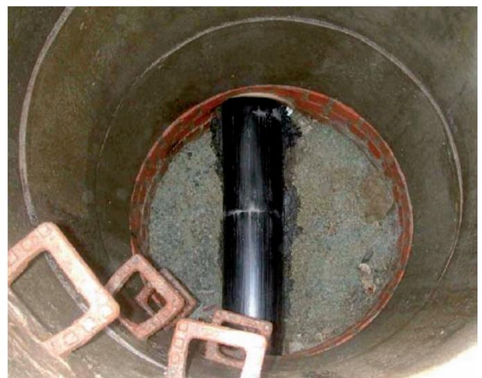
**Bild 12:** Der Langrohrstrang durchfährt einen Zwischenschacht
