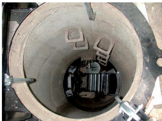
**Bild 8:** Untere in den Schacht abgesenkte Verformungseinheit
