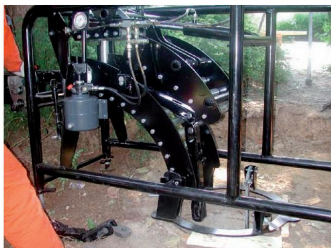
**Bild 7:** Obere auf dem Schacht aufgebaute Verformungseinheit
